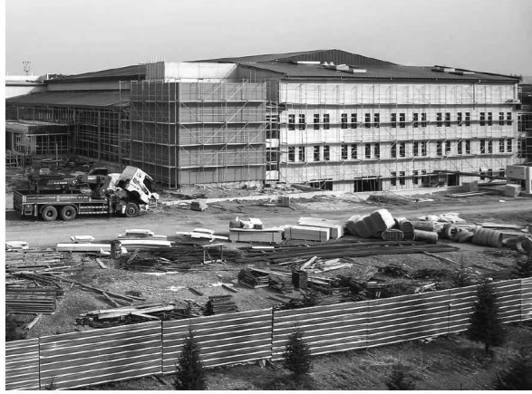
Sincan Cezaevi Yerleşkesi'nde geçen Ağustos ayında inşaatına başlanan salonun yapım çalışmaları son aşamada.
